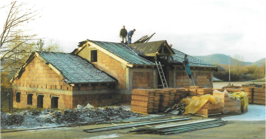
Nachdem der Dachdecker die erste Ziegelreihe angesetzt hatte, wurden von uns die Dachlatten aufgenagelt und das ganze Dach einschließlich der Gauben eingedeckt.
